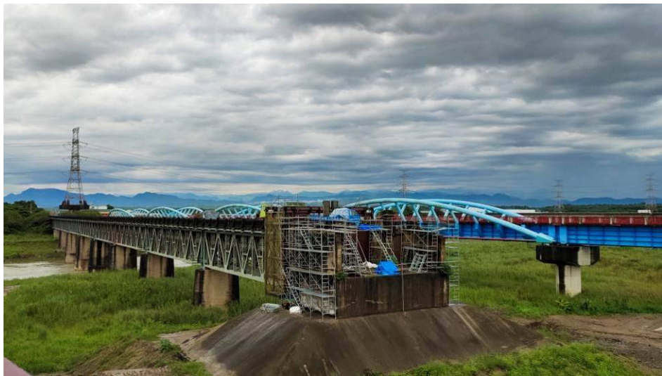
舊曾文溪渡槽橋進行修復工程中
